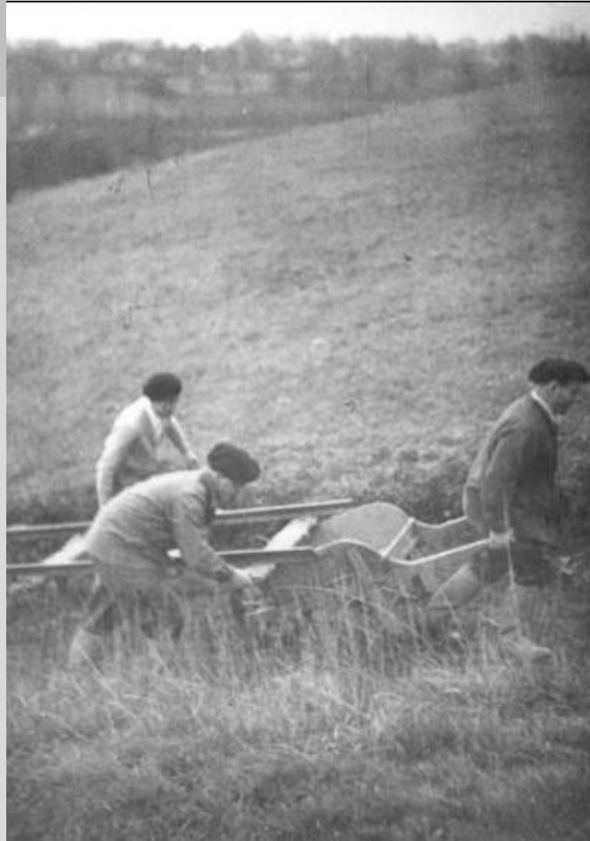
Les brouettes à rails, 1950, Archives privés des Castors de Bayonne
